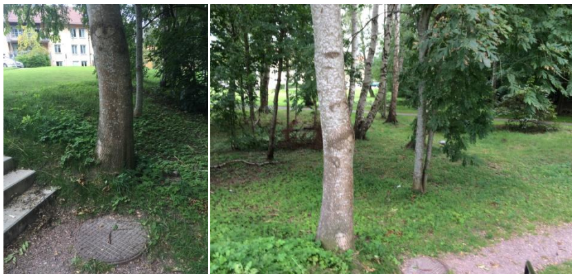
Bild 5 visar punkt 5, kyrkans tomtgräns där ledningar är dragna, Brunnslöck är belagt vid nedgång från trappan från kyrkan ner mot parken, norr om kyrkan.
